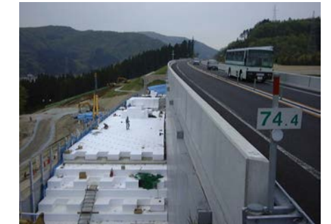
壁構造部分を拡幅する施工例
