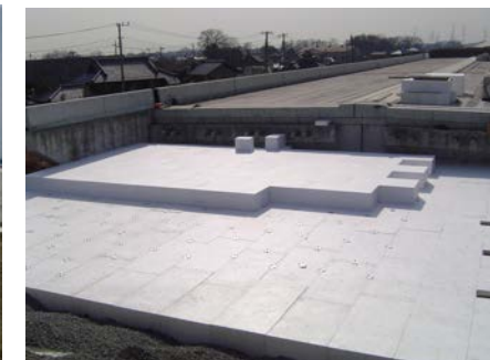
橋の裏側の埋戻し施工例
