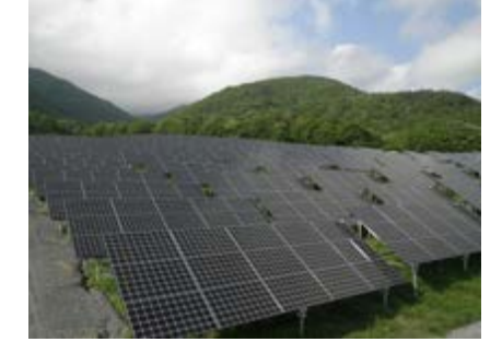
パネル設置完了
