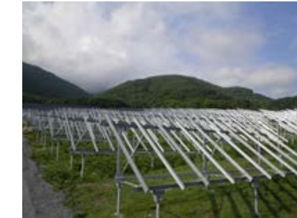
架台組立完了
