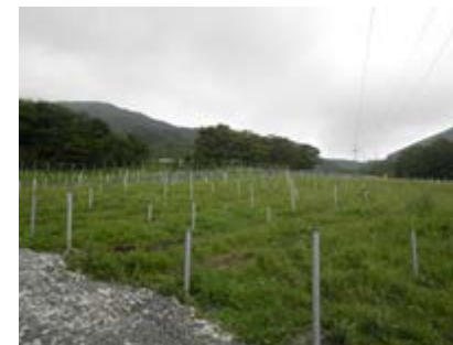
グランドスクリーユ杭施工完了
