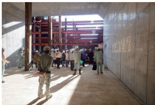
トンネル現場の見学会
