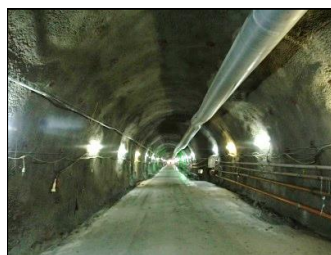
写真5 避難坑拡幅断面 コンクリート舗装
