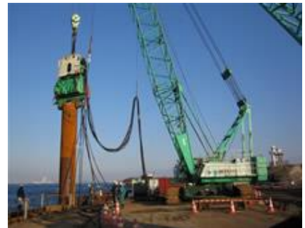
杭の打設状況
