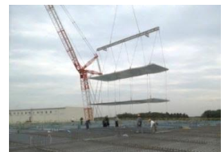
デッキプレート専用吊治具
