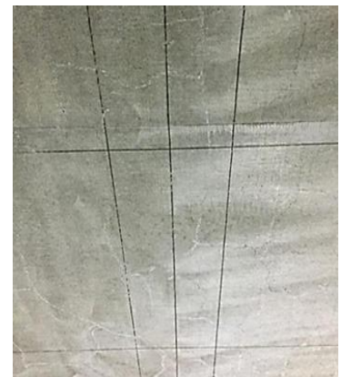
墨打ち後の床版
