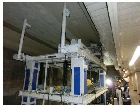
研掃装置による施工状況
