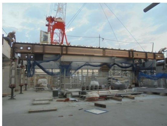
ユニット取付状況
