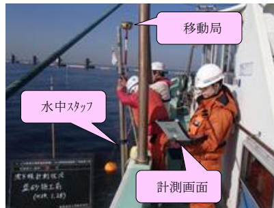
沈下板定期計測
