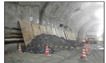
写真4 本坑内ズリ仮置き状況
