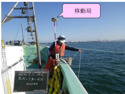
丁張肩位置出し
