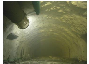
伸縮風管による吸引捕集換気
