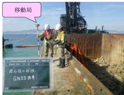
ガット船上での法肩位置出し
