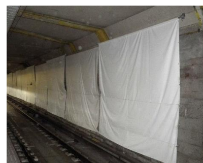
ロールシートによる養生
