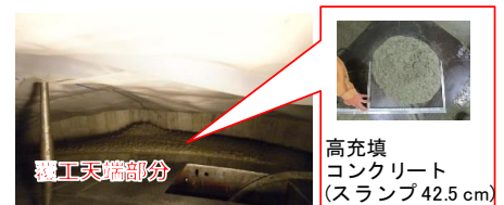
(カイズン後) 吹き上げ打設状況
