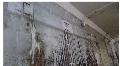
壁面の劣化状況
