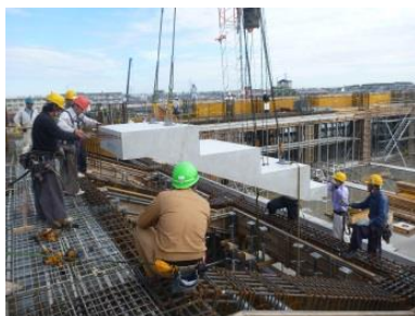
（PCa 段床設置状況）
