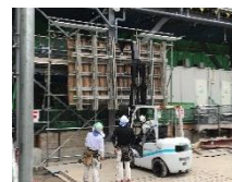
型枠試験施工
