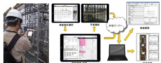
iPadによる配筋検査
