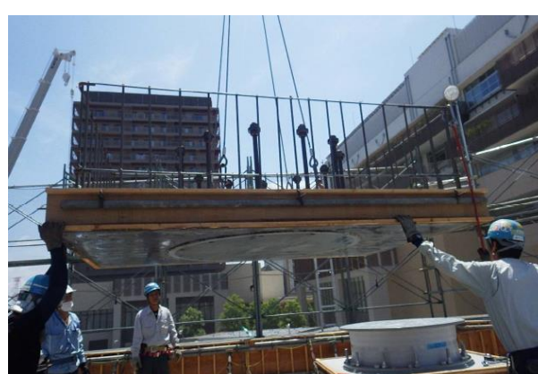
免震上部基礎 PCa 設置状況
