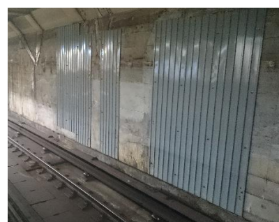
鋼板による養生
