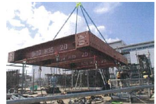
免震上部PC地組吊治具
