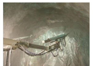
吹付けコンクリート状況
