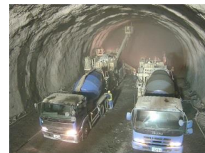
吹付けロボット2台体制
