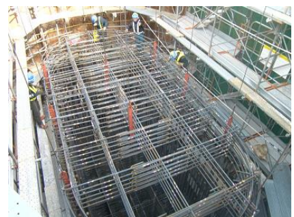
鉄筋のユニット化
