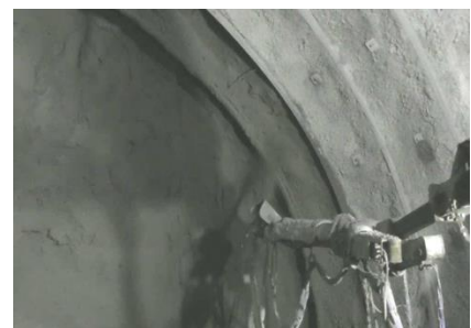
吹付け作業状況 (切羽)
