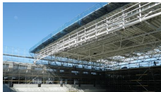
屋根スライド工法施工状況
