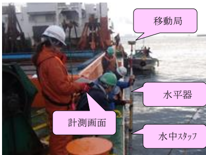
沈下板設置出来形計測
