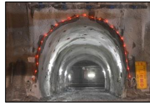
写真2 拡幅した連絡坑
