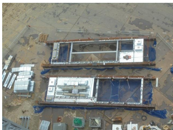
ユニット組立状況
