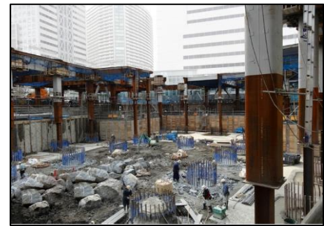
実際の施工状況 （0柱と仮設柱の併用）
