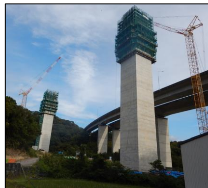
クライミングシステムによる施工状況
