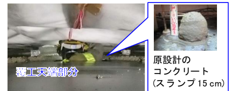
(従来) 狭隘空間での打設状況
