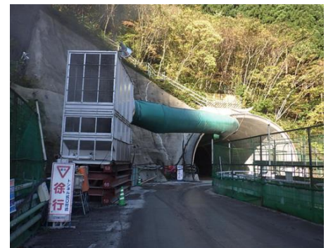
狭隘な坑口部
