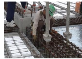
梁支保工の先行設置
