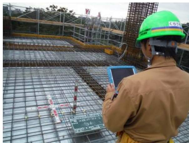
配筋検査状況
