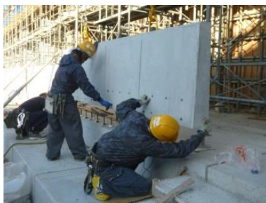
（PCa 腰壁設置状況）
