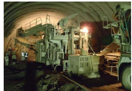
吹付け作業状況 (全景)
