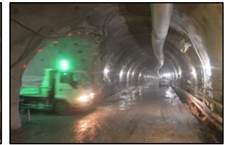
写真3 連絡坑走行状況
