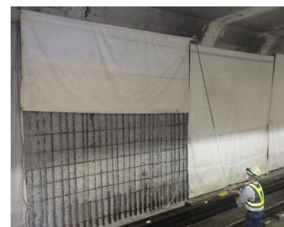
シート巻き取り状況
