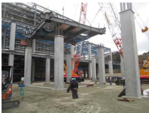
写真 - 5 鉄骨梁ユニット設置作業状況
