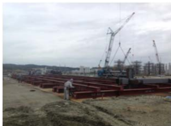
写真-7 柱用地組溶接ヤード設置状況
