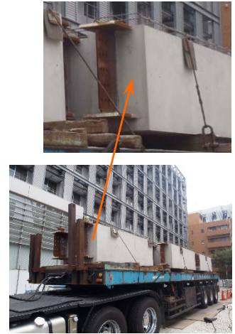
写真 10 搬入された SC 梁
