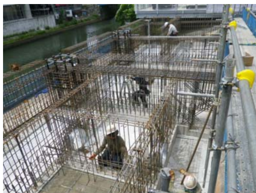
写真-6 基礎上部作業状況
