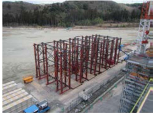
写真-12 地組架台設置状況
