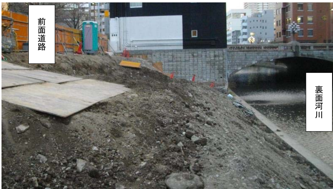
写真-3 敷地状況(着工前)
