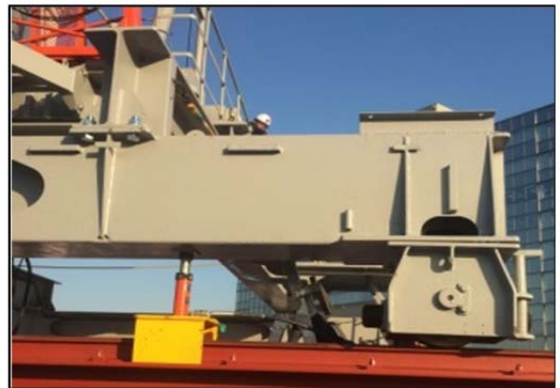
ジャッキアップ時
