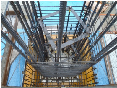
写真-12 ④鉄骨アンカーフレーム設置
