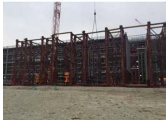
写真-14 同縁ユニット取付状況
