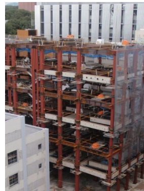
写真 9 架設された SC 梁
