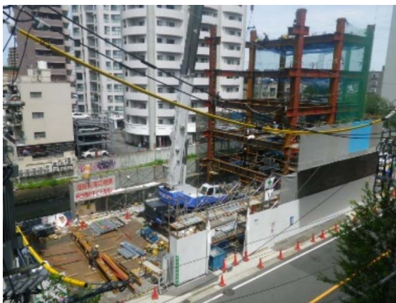
写真-13 鉄骨建て方状況
