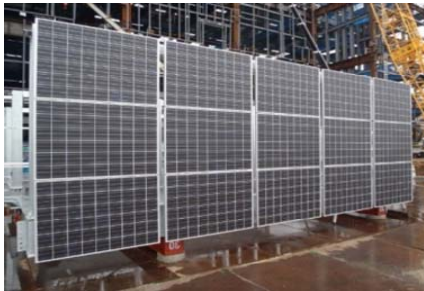
写真-22 バルコニーの地組化
