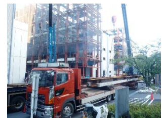
④現場搬入
