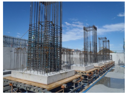
写真-14 コンクリート打設完了
