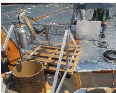
写真-20 CCD カメラ設置状況
