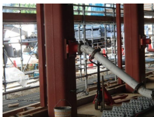
①小径 CFT 柱圧入口
