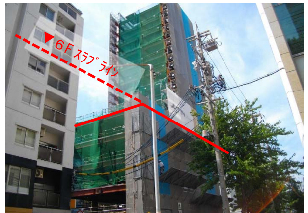
写真-14 6階床コンクリート打設時全景
