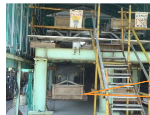
②下フランジコンクリート部の製作
