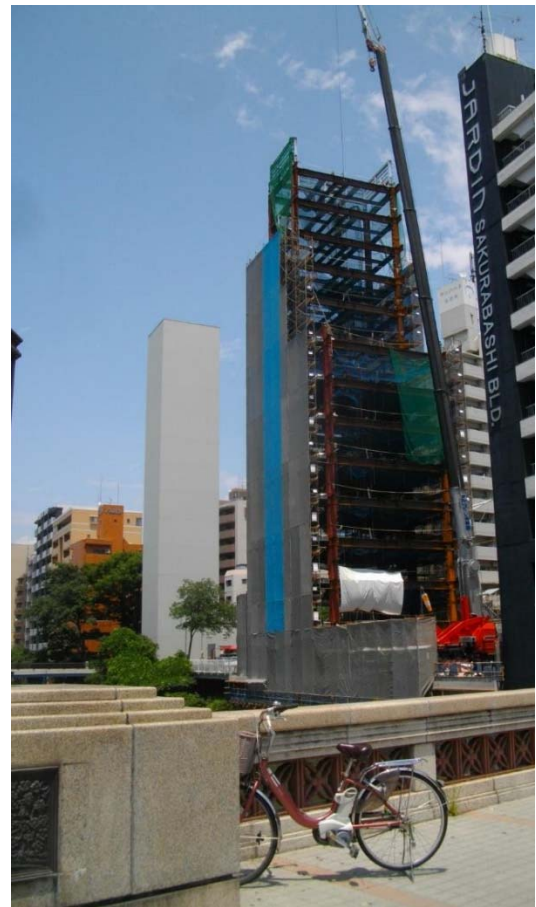
写真-2 河川より鉄骨建て方状況
