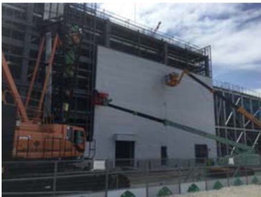
写真-13 外壁ユニット取付状況
