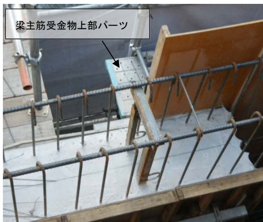
写真－１１ 基礎下部コンクリート打設後
