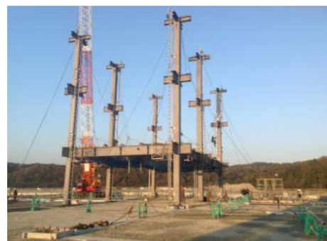
写真 - 11 鉄骨建方状況
