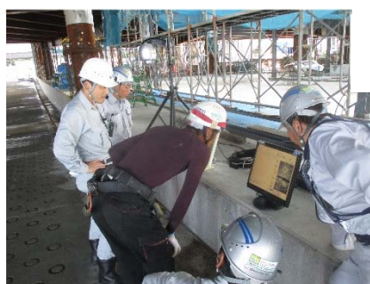
写真-21 打設速度確認状況
