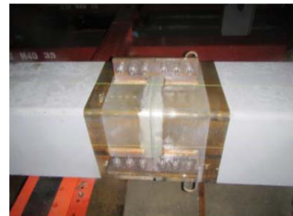
写真 - 10 溶接後精度確認状況
