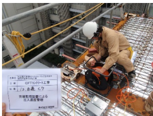
③圧入速度管理状況
