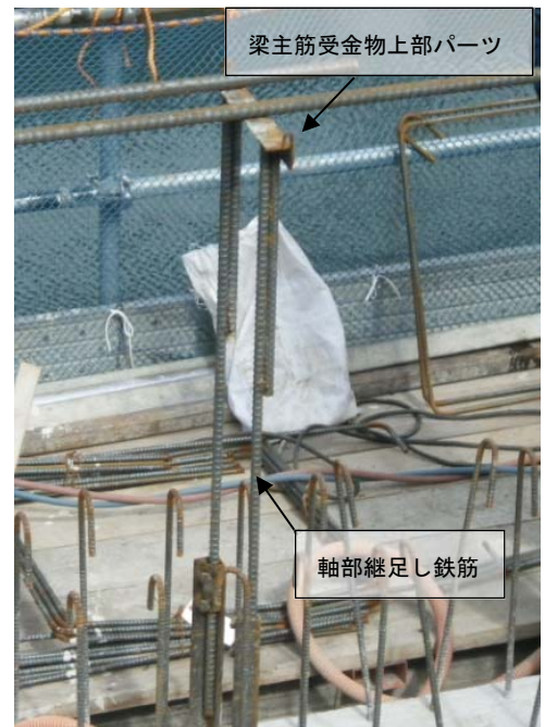
写真－１２ 上部基礎配筋時
