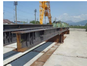
①製作された鉄骨梁
