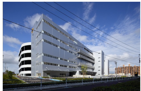
写真-2 建物全景
