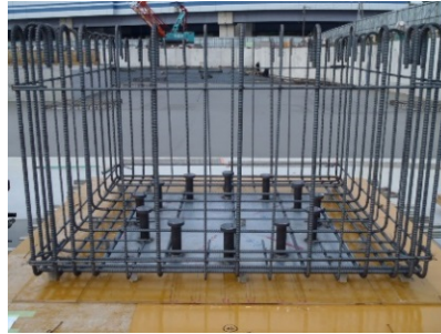
写真-10 ②上部基礎配筋
