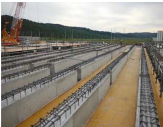
写真 - 3 基礎大梁・基礎小梁のサイトPCa化
