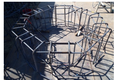
写真-8 免震補強筋地組
