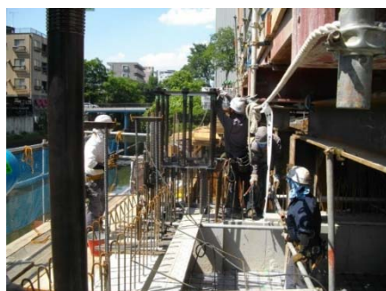
写真-9 アンカーボルト設置
