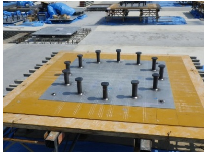
写真-9 ①型枠上部プレート設置・墨出し
