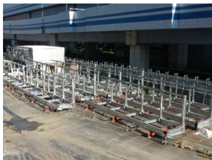
写真-23 地組ヤード
