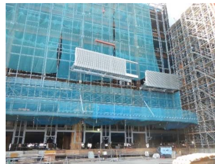
写真-24 地組材設置状況
