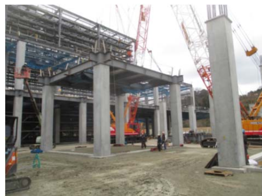
写真 - 6 鉄骨梁ユニット設置完了状況
