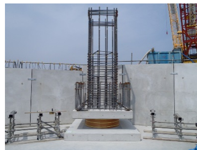
写真-16 サイトPC設置完了
