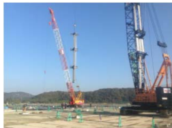
写真-8 地組鉄骨柱建方状況
