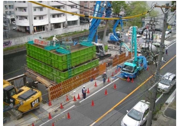
写真－5 杭工事+土工事
