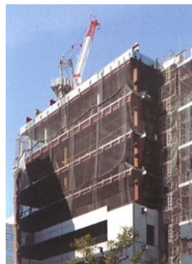
写真－3 クレーン設置状況
