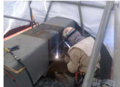
写真 - 9 地組先行溶接作業状況
