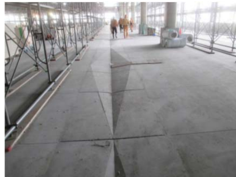
写真 - 15 複雑な形状の勾配床排水溝
