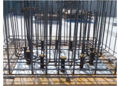
写真-11 ③免震補強筋設置
