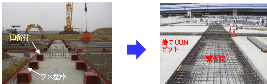
写真-5 捨てコンピット先行型
