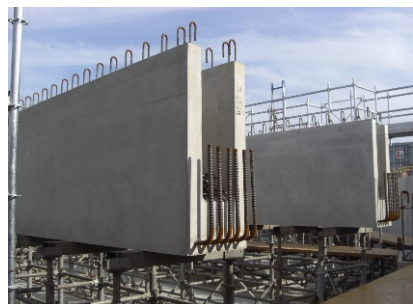
写真-17 小梁PCaの軽量化
