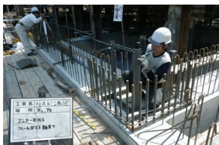
写真-8 アンカーフレーム設置
