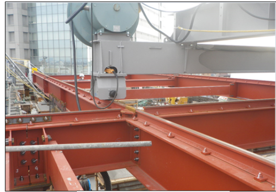
走行レール交差部
