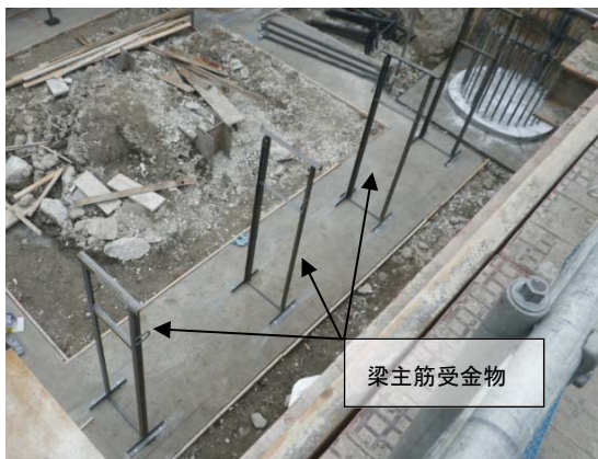
写真－１０ 梁主筋受け金物設置状況
