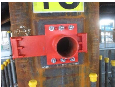
写真-18 CFT 圧入孔
