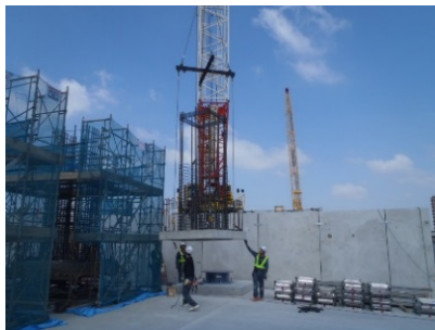
写真-15 サイトPC設置状況
