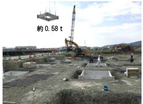
写真 - 2 基礎型枠PCa揚重・据付状況
