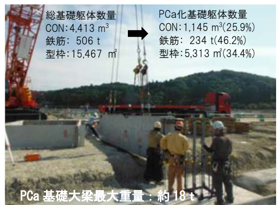
写真 - 4 基礎大梁サイトPCaの設置状況
