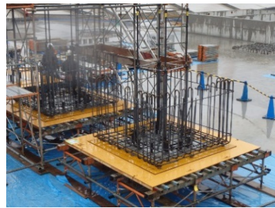
写真-13 ⑤柱配筋
