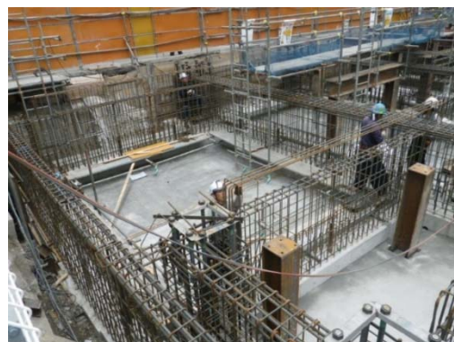
写真-7 基礎上部作業状況
