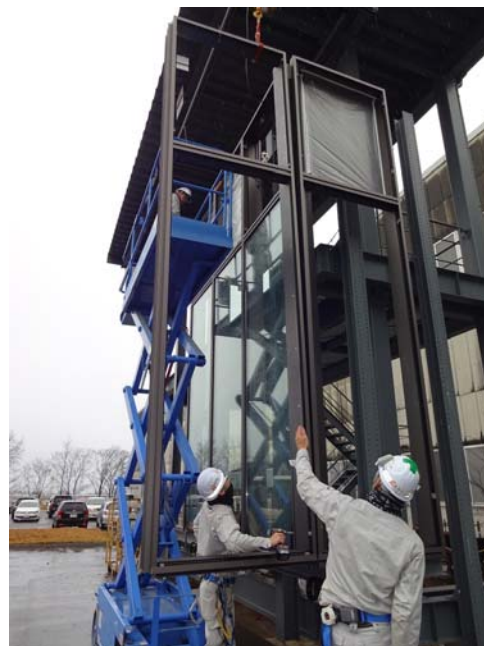
写真-3 施工試験状況
