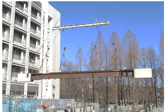
写真-12 TO-RCSB 梁地組後揚重状況
