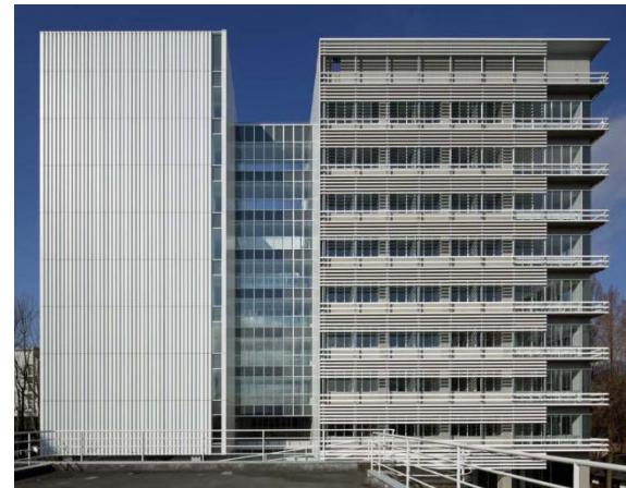
写真-2 竣工時写真（東正面）
