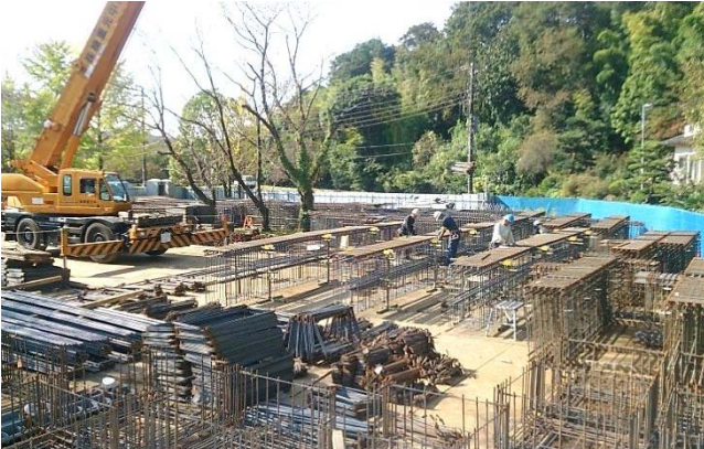
写真-8 地組ヤード施工状況
