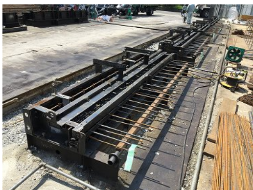
写真－８ 鋼製型枠セット
