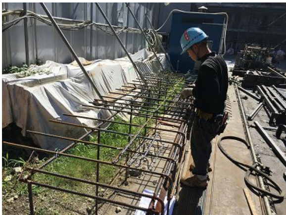
写真-4 鼻先鉄筋ユニット組立て状況
