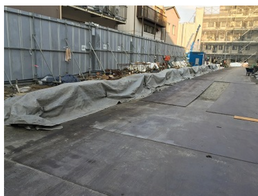
写真－１１ シート閉め・蒸気養生
