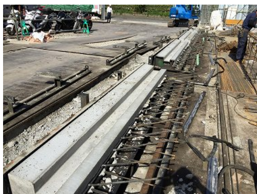
写真－５ 型枠脱型・出来型
