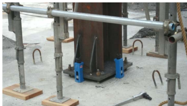
写真-7 構台杭脚階建入れ調整治具セット状況
