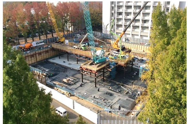
写真-3 基礎工事中状況写真
