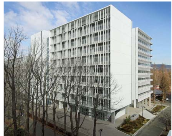
写真-1 竣工時写真（南東面）
