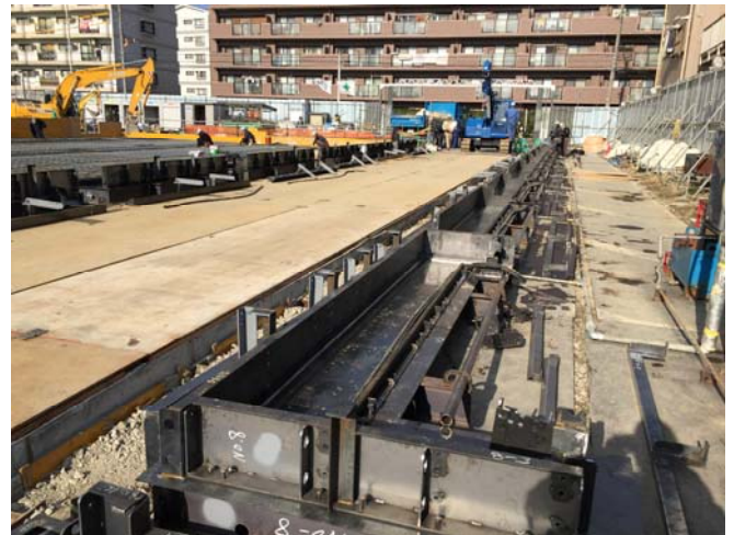
写真-2 鼻先PCa型枠組立完了状況
