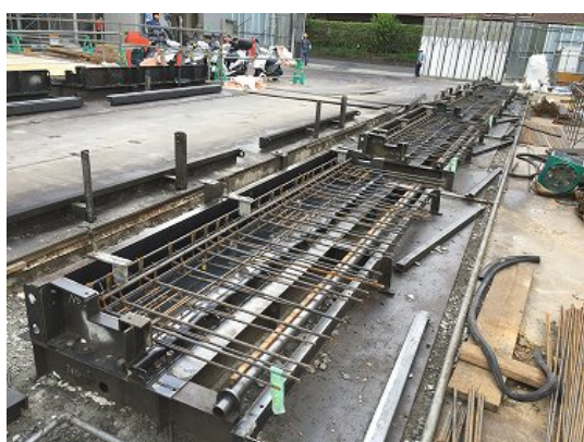
写真－７ 鼻先鉄筋ユニットセット
