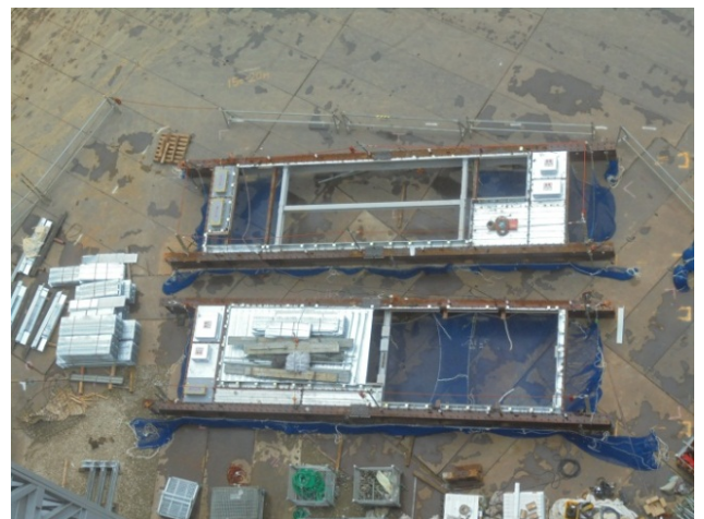
写真-5 デッキプレート敷き込み 安全設備（ネット・親綱）セット状況
