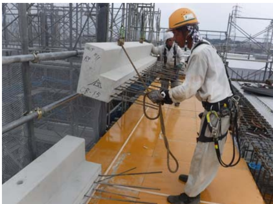
写真-13 鼻先 PCa 取付け状況
