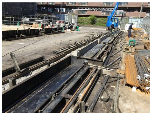
写真－６ 型枠清掃・剥離材散布
