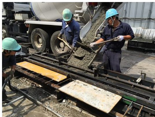
写真－９ コンクリート打設
