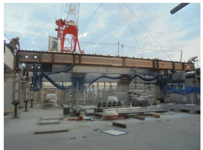
写真-7 ユニット化された鉄骨の 取り付け状況
