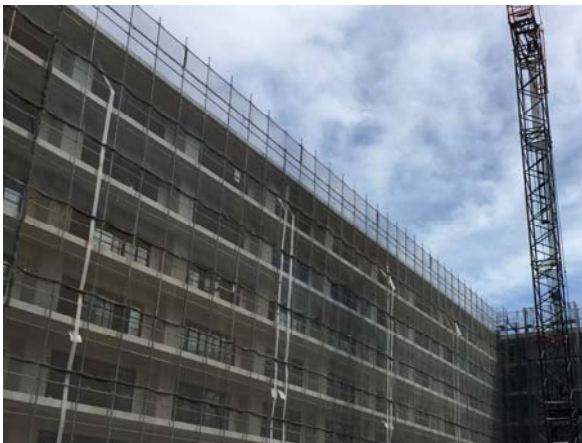
写真-1 無足場部垂直養生
