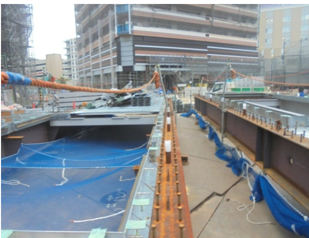
写真-6 安全設備（ネット・親綱） セット状況
