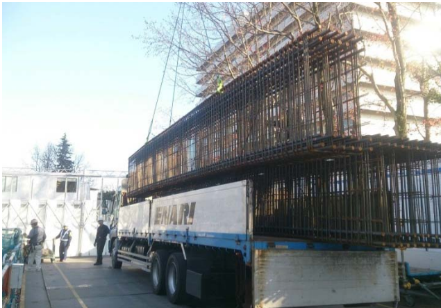
写真-9 地組梁小運搬 (外部地組ヤード → 場内)
