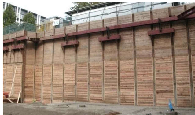
写真-5 下段腹起しの不連続設置
