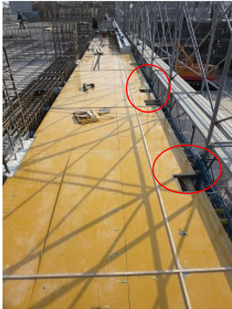
写真-12 外床スラブ型枠状況
