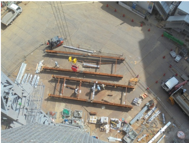
写真-4 鉄骨梁の地組状況
