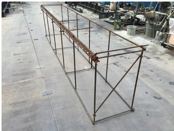
写真-3 鼻先鉄筋ユニット架台
