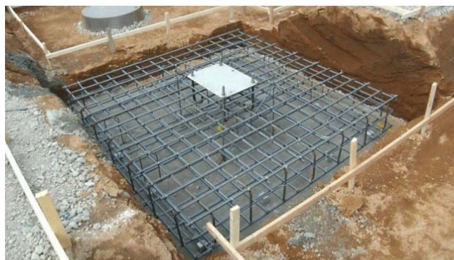
写真-6 構台支柱独立RC基礎躯体配筋状況
