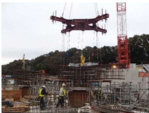
写真3.3 免震上部基礎 据付
