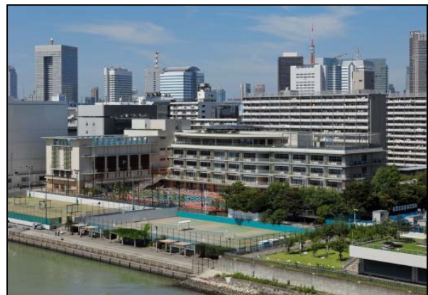
写真-1 完成写真
