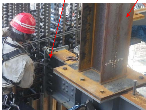
写真-3 鉄骨梁のRC造との取合い部
