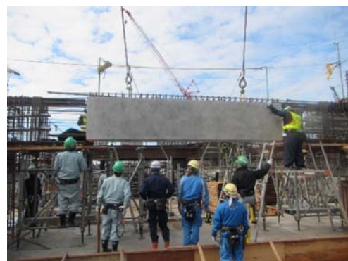
写真3.4 1F大梁 据付
