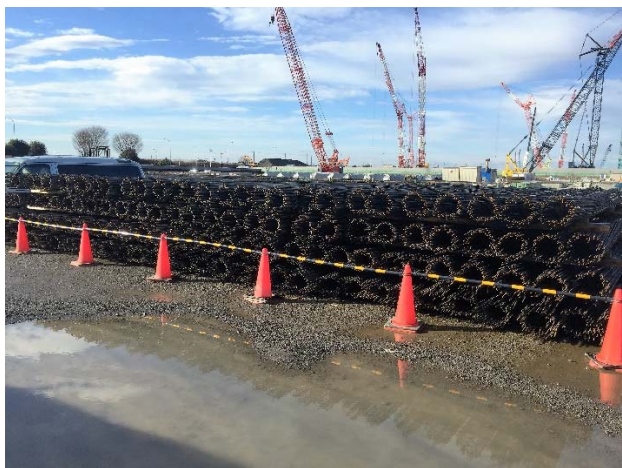
写真3. 10 ロールユニットのストックヤード
