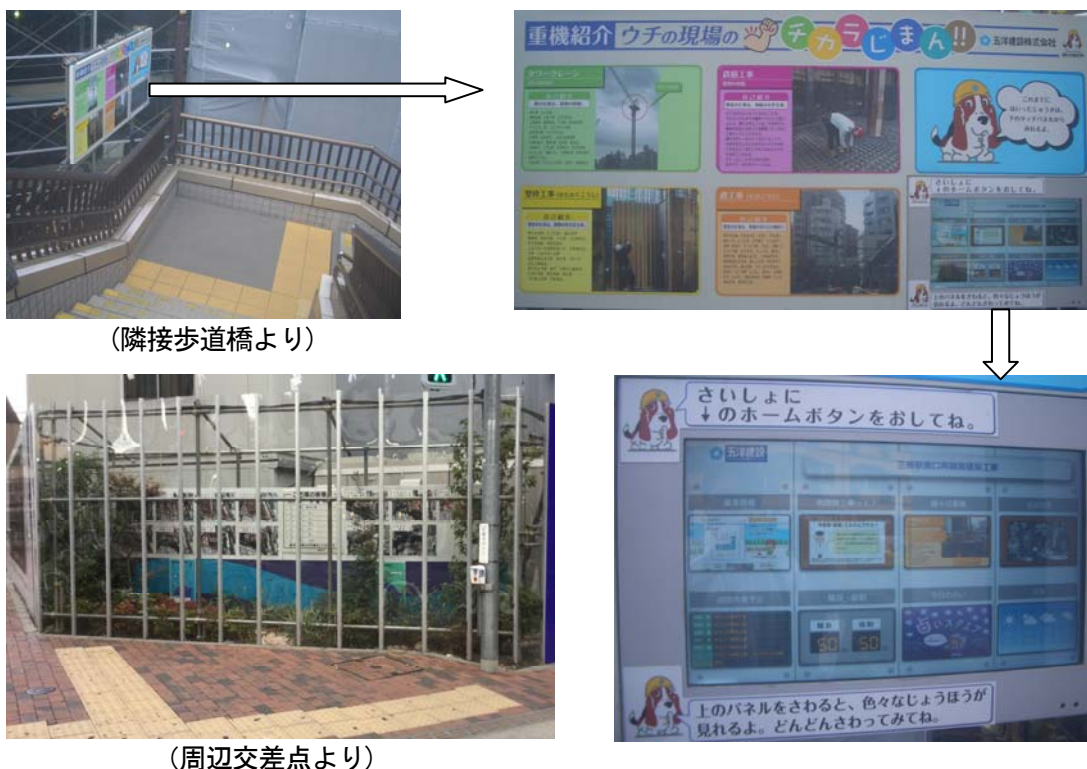
写真－5 仮囲いの環境面の工夫
