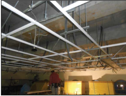
写真-2 施工状況
