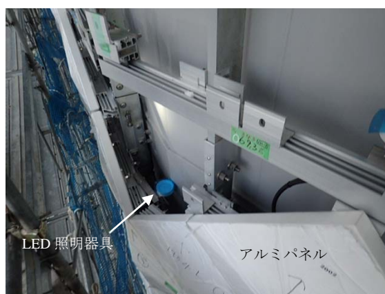
写真13 外装照明器具設置状況 (パネル取り合い)
