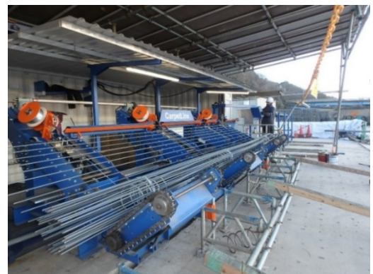
写真3.9 スピンマスターの現場設置
