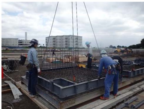
写真3.1 サイトPCa擁壁 鋼製型枠
