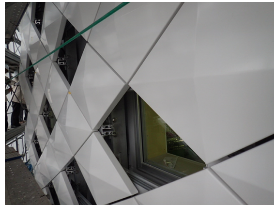
写真9 外装パネル施工状況
