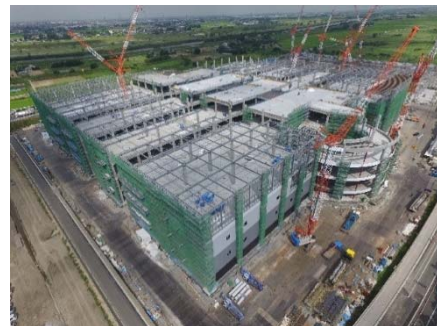
写真2.1 工事全景(南東側より撮影)
