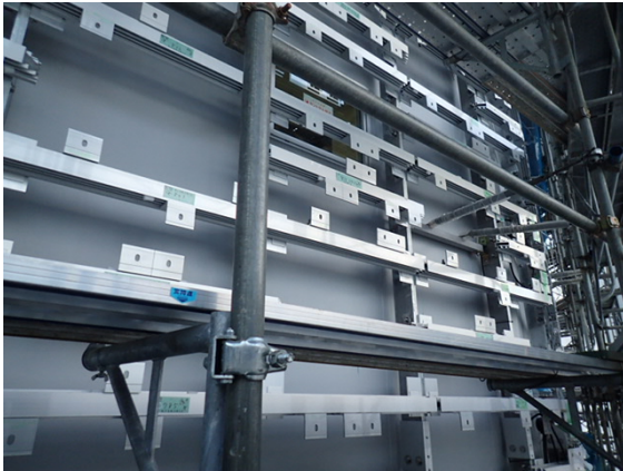
写真 2 方立 & 特殊無目設置状況
