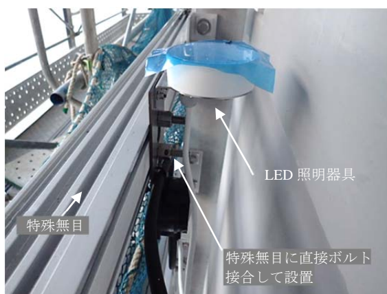
写真12 外装照明器具設置状況
