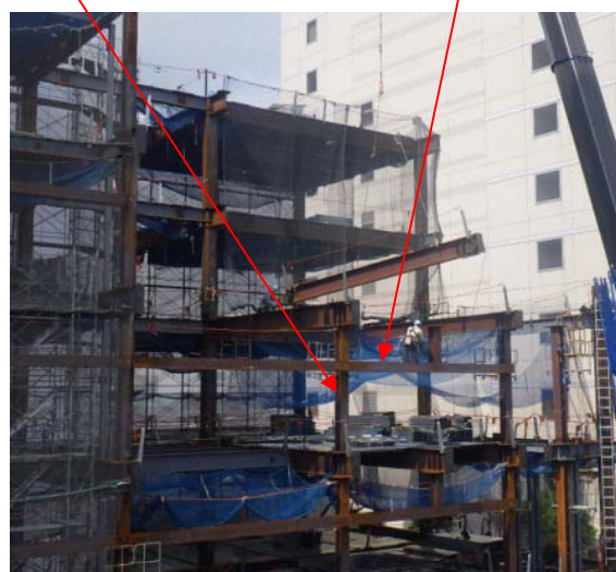
写真-2 鉄骨建方先行状況
