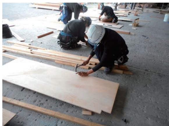
型枠加工実習
