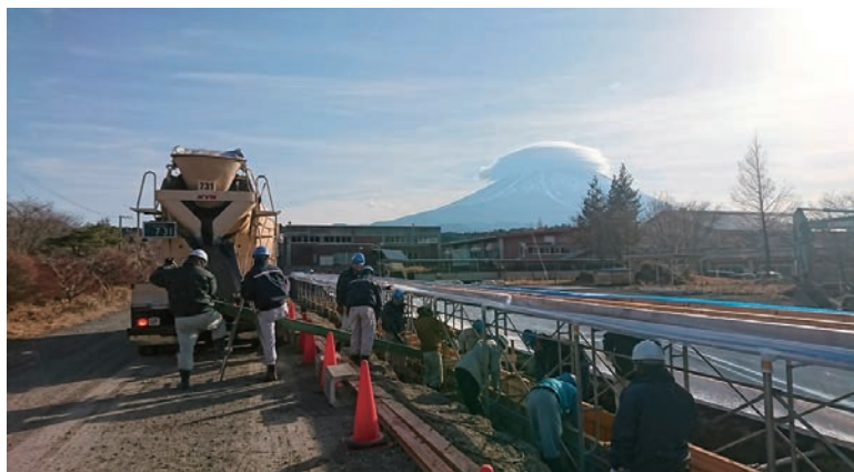
土木施工実習
