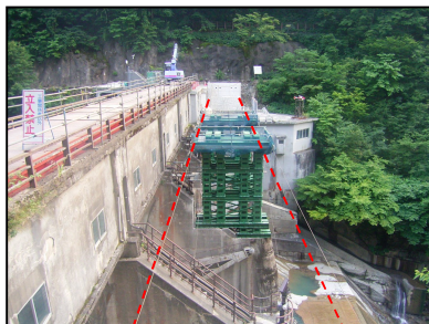
仮設橋脚(ベント)
