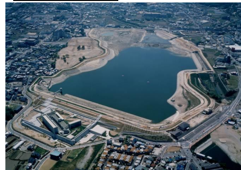
狭山池ダム改修後
