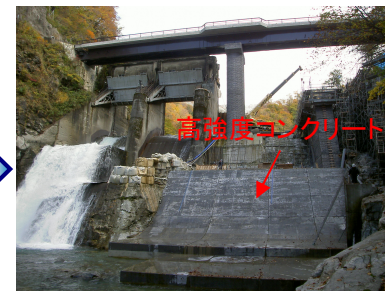
高強度コンクリートの下流面 高強度コンクリート
