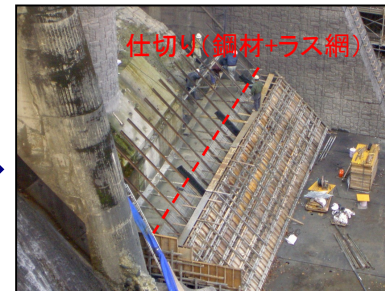
コンクリート打設状況 仕切り(鋼材+ラス網)
