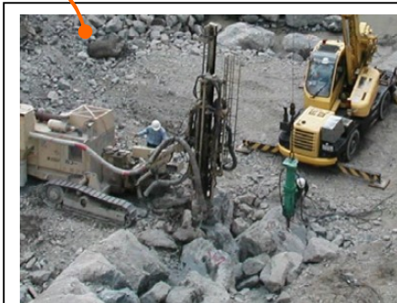
ビッカー工法による割裂状況
