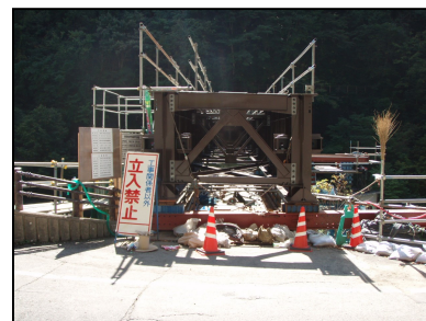
桁地組(既設橋梁上) 立入禁止
