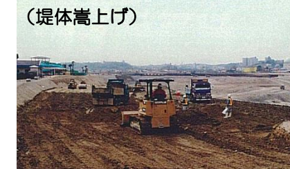
狭山池ダム堤体嵩上げ・池内掘削状況
