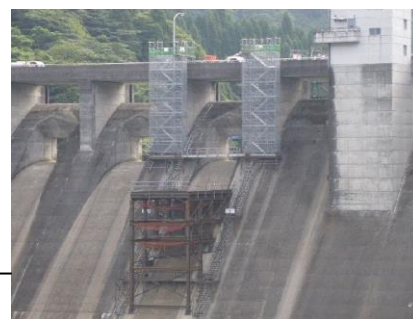
組立作業構台
