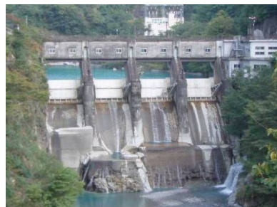
改修前の下流面
