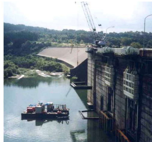
上流仮締切設置状況（1）
