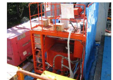
基材用ミキシングプラント
