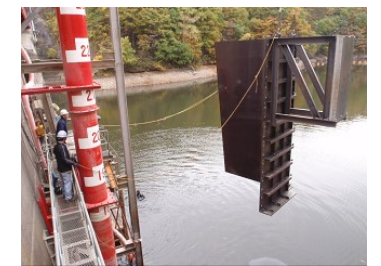
水中コンクリート型枠
