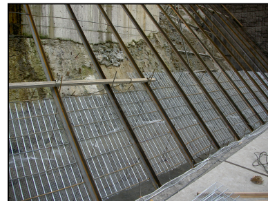
埋設型枠(鋼材+ラス網)
