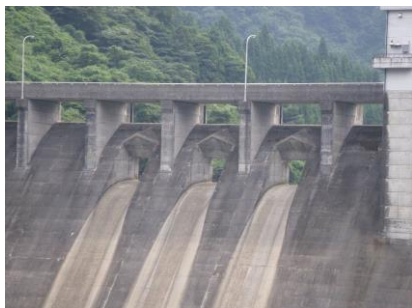
工事着手前の常用洪水吐(下流側)
