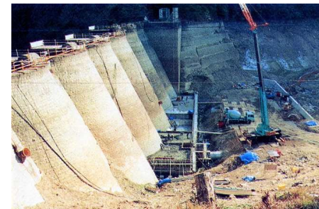
上流フーチングコンクリート 施工状況
