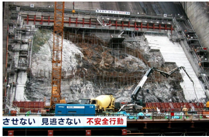
破損コンクリート撤去完了
