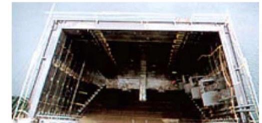
上流仮締切設置状況（2）
