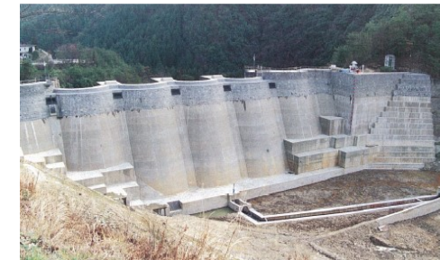
補強完成（上流側）
