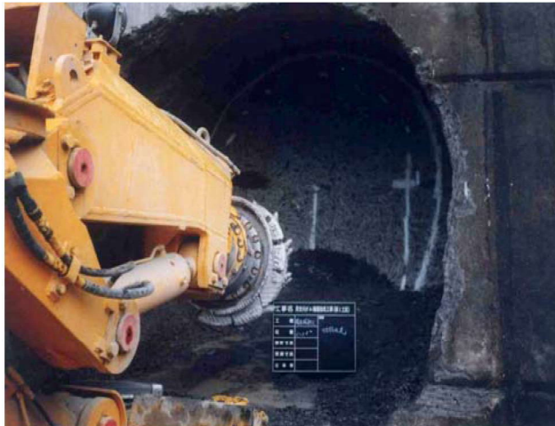
自由断面掘削機による取壊し
