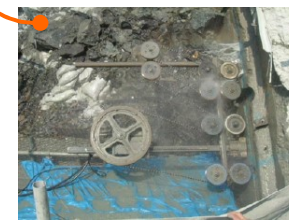
岩盤背面および水平壁面をダイヤモンドワイヤーソーにより切断
