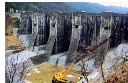
補強完成（下流側）
