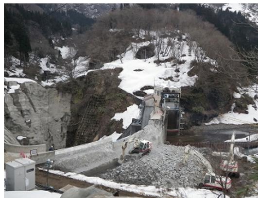
機械掘削状況
