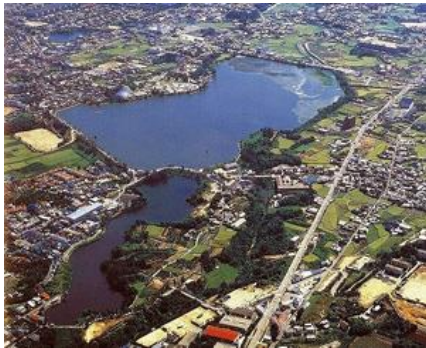
狭山池ダム改修前
