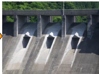
完成した常用洪水吐(下流側)
