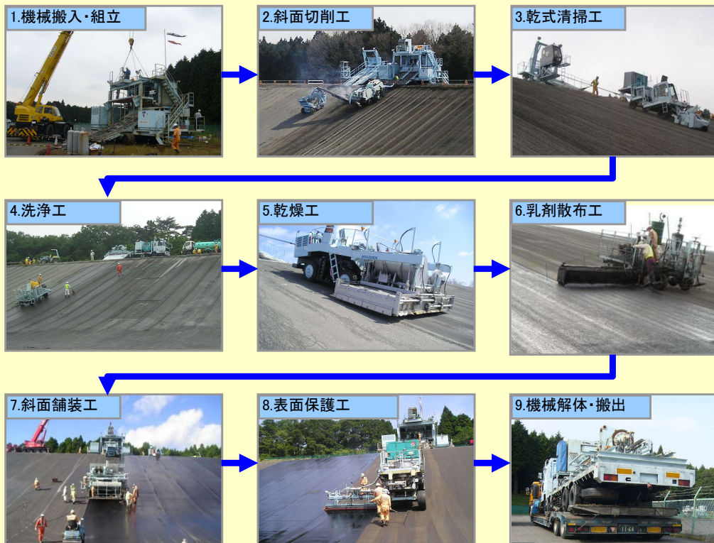
施工状況写真(施工手順)
