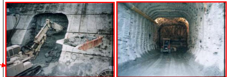
写真-2 堤体掘削状況
