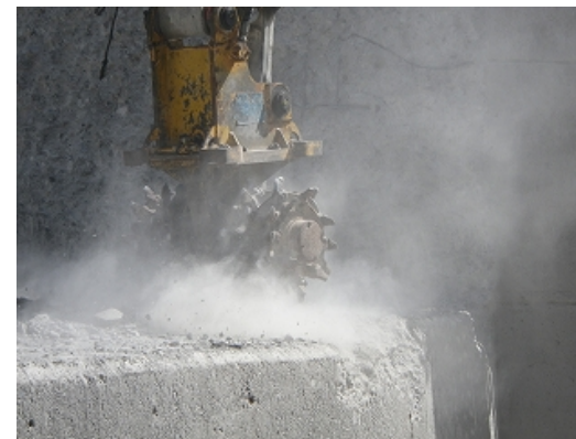
ツインヘッドによる整形状況
