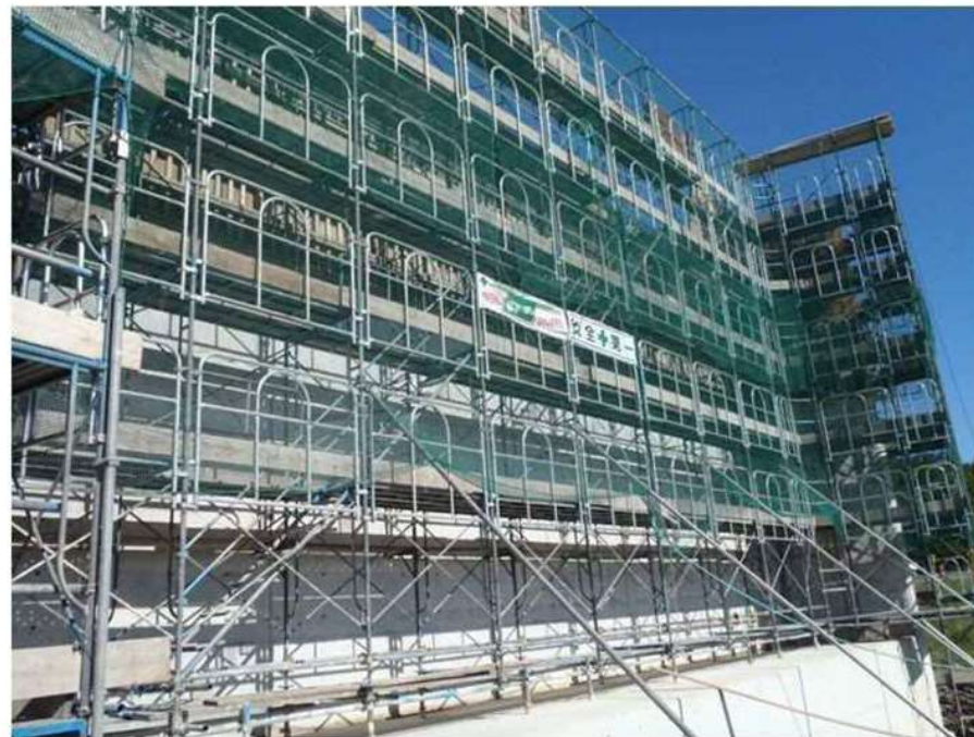
枠組足場(ビティ)
