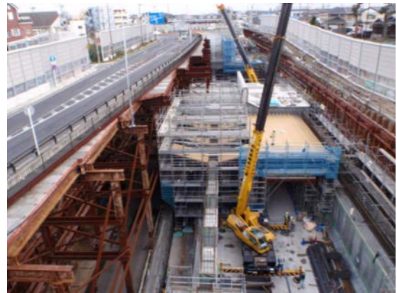
写真-1 躯体構築状況(内回り)
