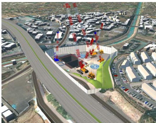
発進立坑部施工モデル
