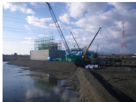
写真-1 O-P6 施工状況
