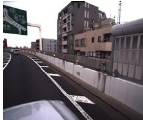
写真を撮影・レーザで座標測定
