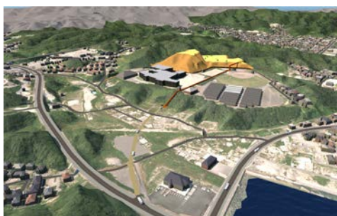
施工状況を可視化
