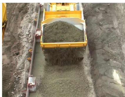
コンクリート打設状況
