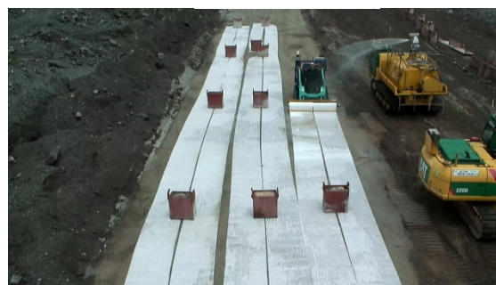
養生、散水状況
