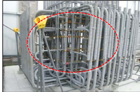
⑤配筋変更案での実物大模型製作
