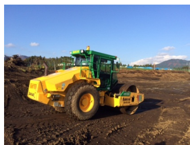
振動ローラ (転圧管理システム)
