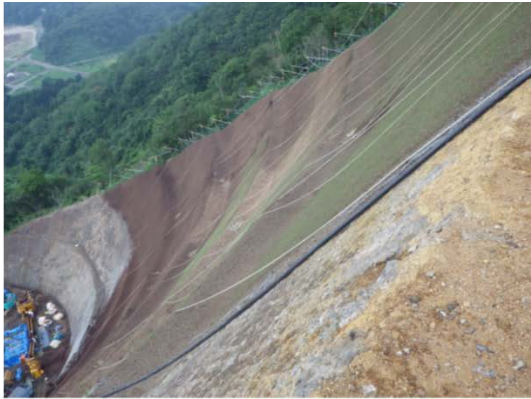
曲線法面(取付道路) 写真1
