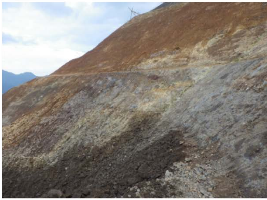
法面屈折部(入隅部) 写真3
