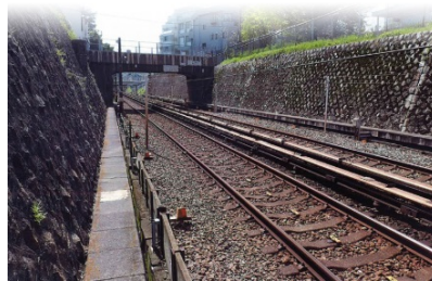
(施工前現場状況)
