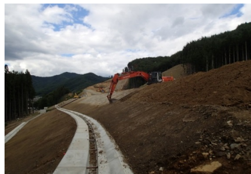
マシンガイダンス BH による施工
