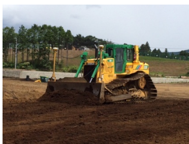
ブルドーザ (マシンコントロール)
