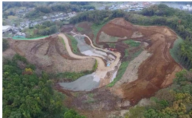
写真-1 厚木森の里施工エリア空撮
