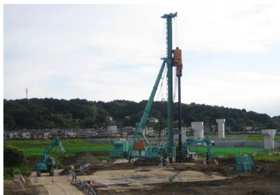
図-1 地盤改良施工状況
