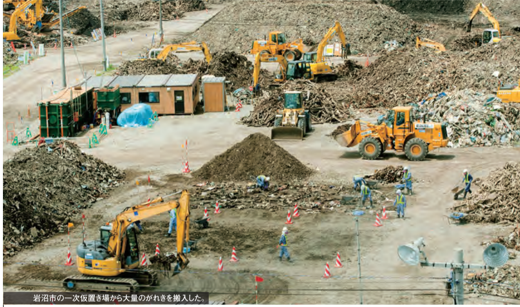
岩沼市の一次仮置き場から大量のがれきを搬入した。
