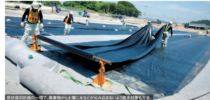
原状復旧計画の一環で、廃棄物から土壌に水などがしみ込まないよう遮水対策も万全
