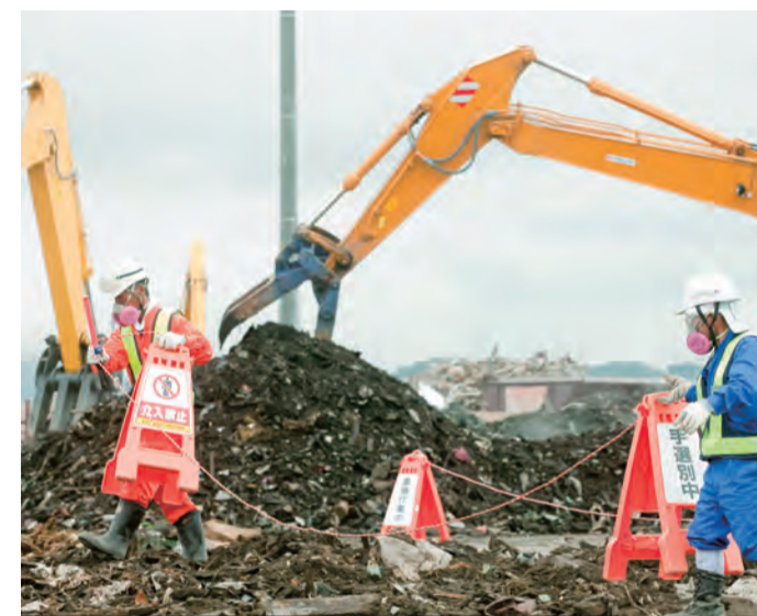
重機を使ってガレキを選別する作業。写真や思い出しの品が発見されれば保管する。
