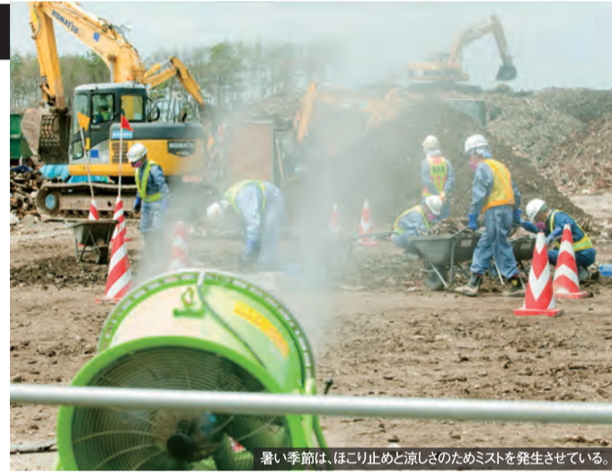
暑い季節は、ほこり止めと涼しさのためミストを発生させている。
