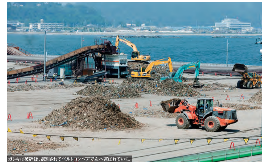
ガレキは破碎後、選別されてベルトコンベアで次へ運ばれていく。
