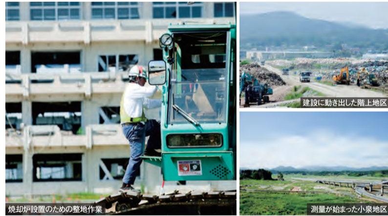
焼却炉設置のための整地作業
