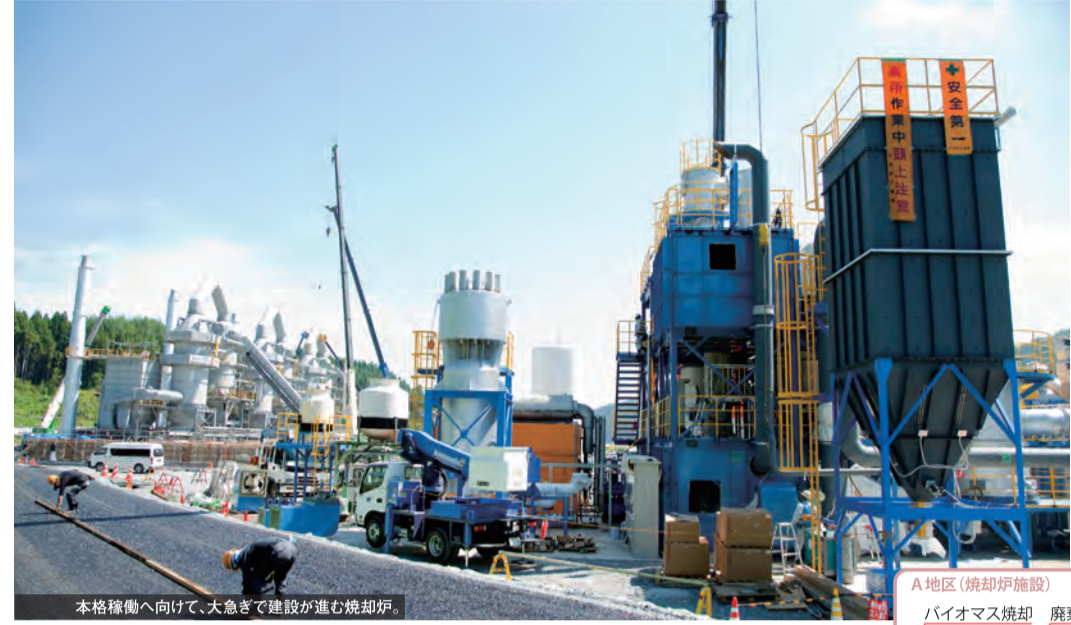
本格稼働へ向けて、大急ぎで建設が進む焼却炉
