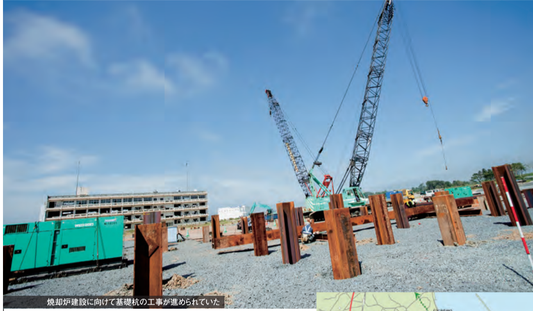
焼却炉建設に向けて基礎杭の工事が進められていた
