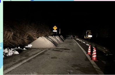
能越自動車道(穴水道路)の道路啓開作業
