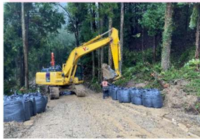
国道249号線の啓開作業
