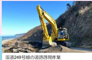
国道249号線の道路啓開作業
