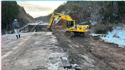
能越自動車道(穴水道路)の道路啓開作業
