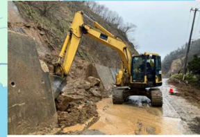
県道26号線の道路啓開作業
