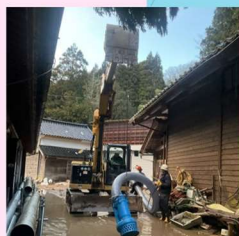
広地川応急対策作業
