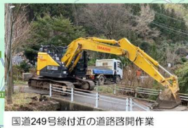
国道249号線付近の道路啓開作業
