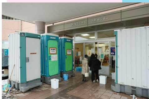
仮設トイレの設置 (輪島市ふれあい健康センター) (北陸地方整備局より提供)
