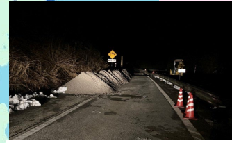
能越自動車道(穴水道路)の道路啓開作業
