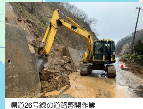
県道26号線の道路啓開作業
