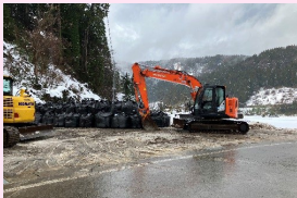
河原田川(市ノ瀬地区)応急対策作業
