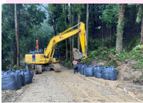
国道249号線の啓開作業
