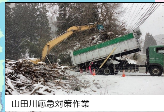
山田川(能登町)応急対策作業
