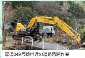
国道249号線付近の道路啓開作業
