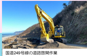
国道249号線の道路啓開作業
