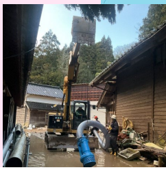
広地川(志賀町)応急対策作業
