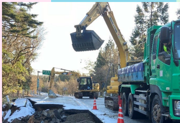
能越自動車道(のと里山海道)の道路啓開作業
