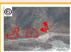
R249地すべり (輪島市名舟町) 【国交省】大成建設
