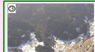
紅葉川(輪島市市ノ瀬町) 【石川県】鹿島建設 【国交省】鹿島建設
