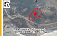
R249地すべり (輪島市大野町・深見町) 【国交省】清水建設
