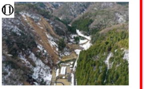
角間川(珠洲市) 【石川県】大成建設
