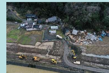
現場上空写真
