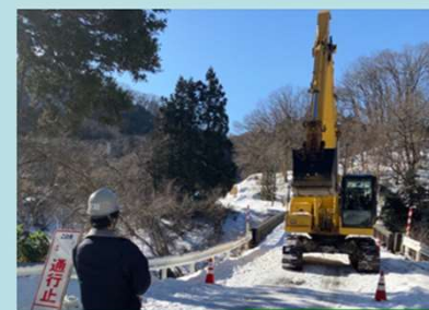
遠隔操作施工機械の走行状況
