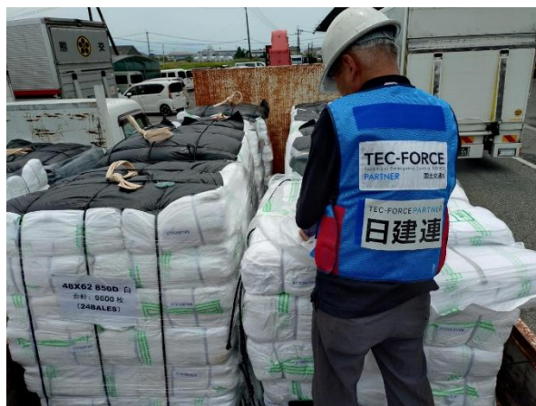
（八代市への土のう袋搬入）
