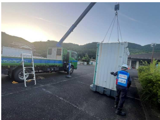
（二見コミセンへの仮設簡易トイレの設置）
