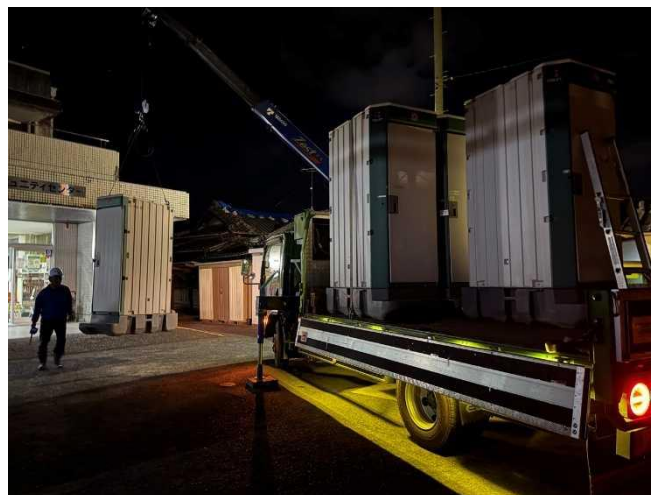
（宮地コミセンへの仮設簡易トイレの設置）
