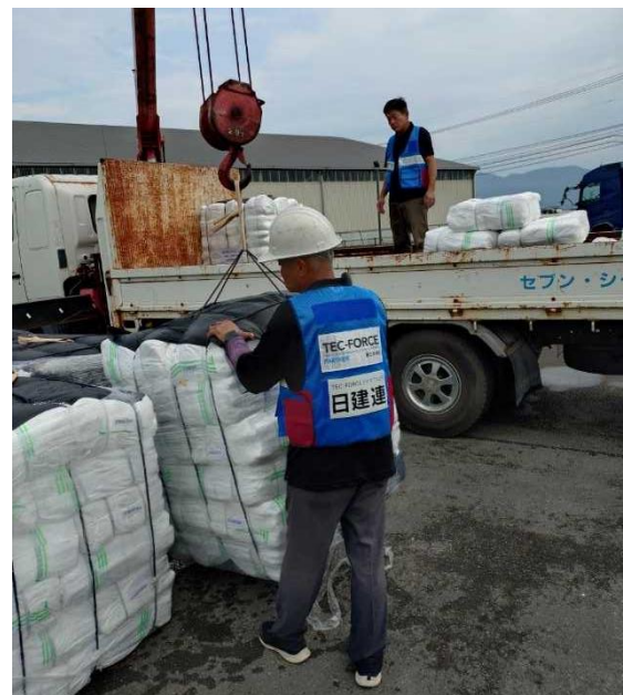
（氷川町への土のう袋搬入）
