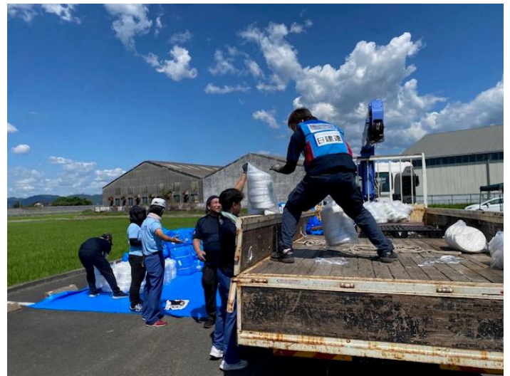
（氷川町への土のう袋搬入）
