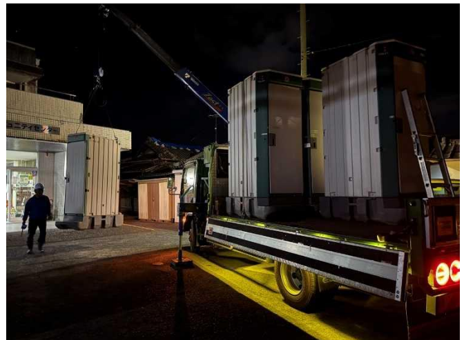
（宮地コミセンへの仮設簡易トイレの設置）
