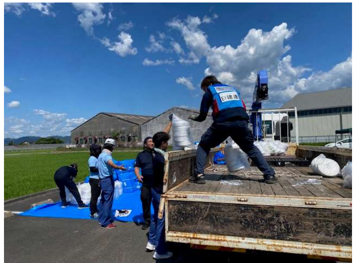
（氷川町への土のう袋搬入）
