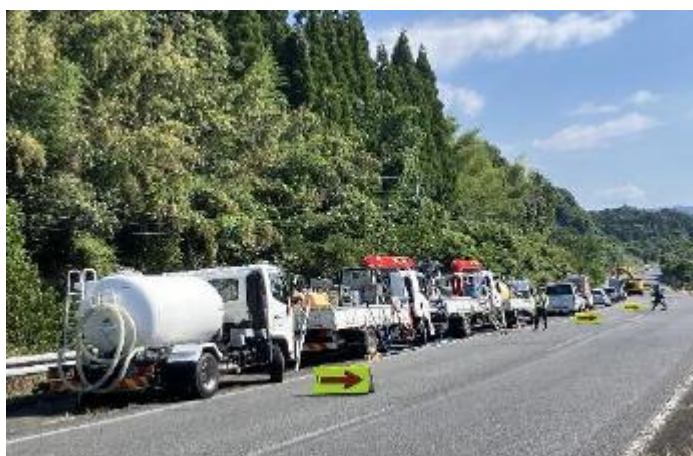
(ボックスカルバートのズレ箇所へのエアミルク充填)
