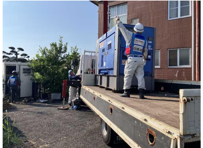
（八代市内の老人ホームへの発電機設置）
