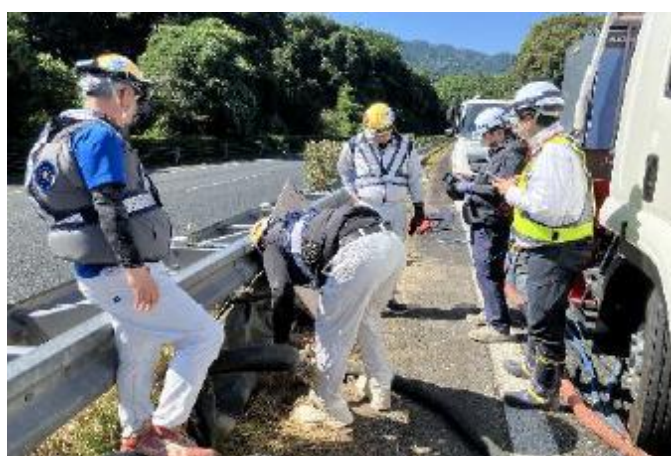
(ボックスカルバートのズレ箇所へのエアミルク充填)
