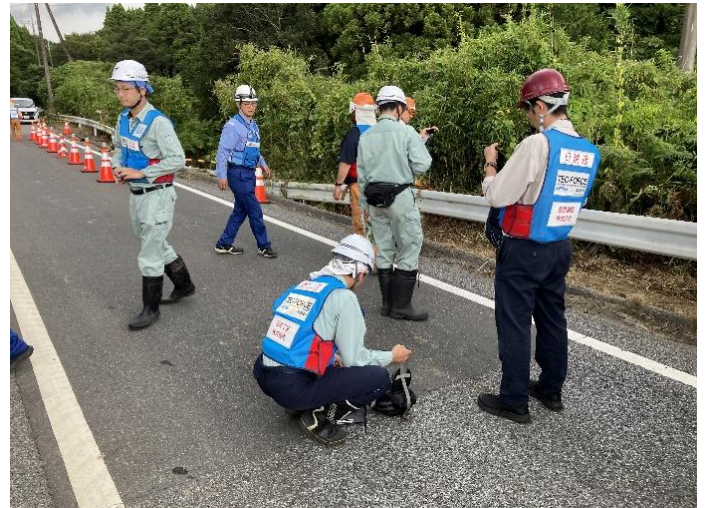
(被災箇所の現地調査)
