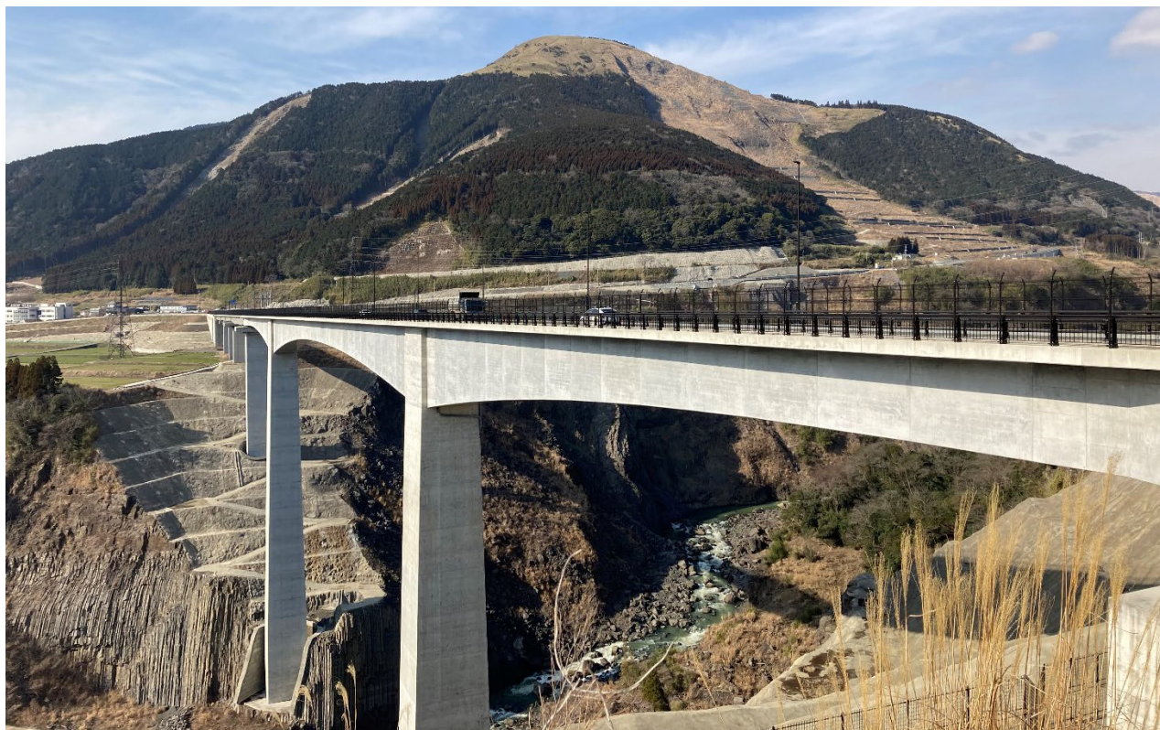
Fig.6 新阿蘇大橋（全景）
