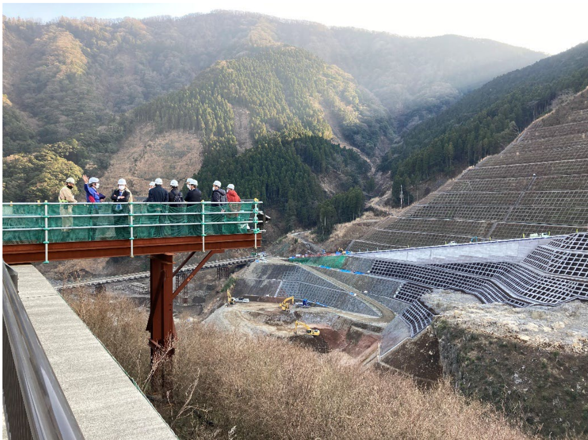
Fig.10 施工状況の視察
