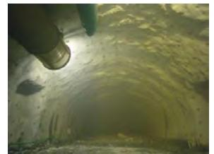
伸縮風管による吸引捕集換気
