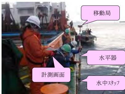
沈下板設置出来形計測
