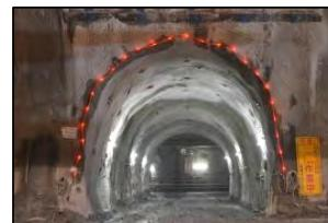
写真2 拡幅した連絡坑
