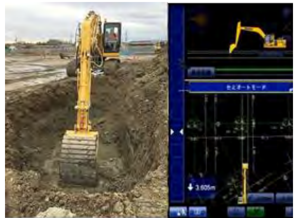
写真3 ICT建機による杭頭レベル確認
