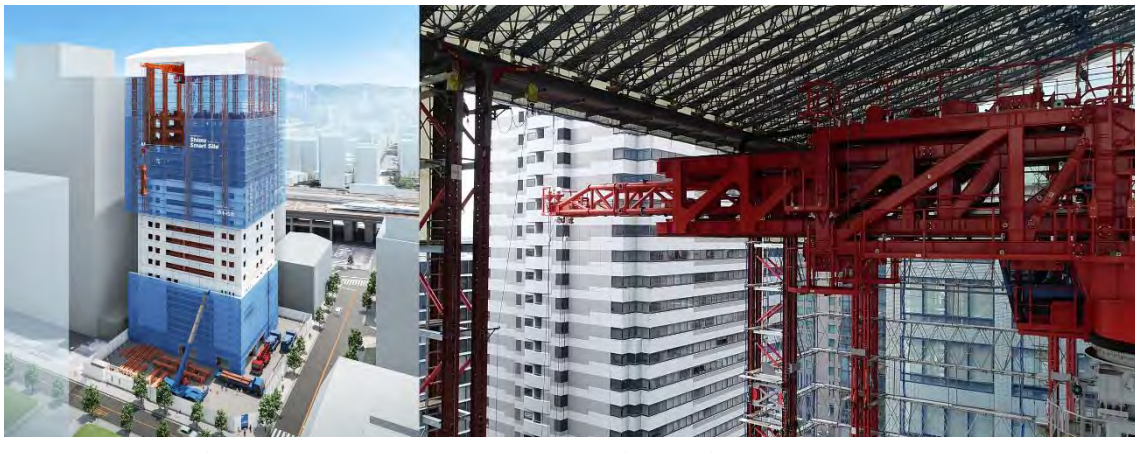
全天候カバー、スライドクレーンのイメージとカバーの中から揚重を行う Exter
