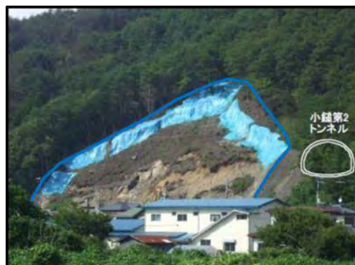
東日本大震災による斜面崩壊
