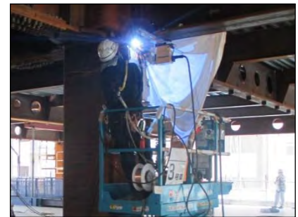
梁下フランジの上向溶接
