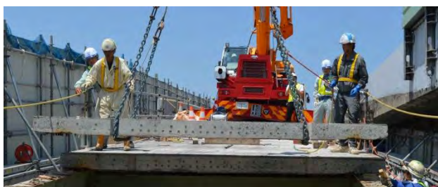
写真-3 床版の横断方向一括撤去
