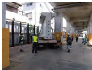
高架下への曲線路運搬
