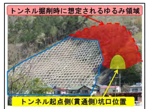
法面对策工事とトンネル位置
