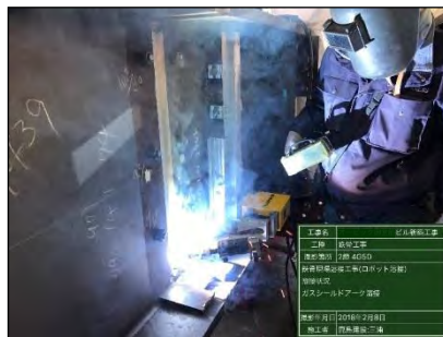
梁ウェブの立向溶接
