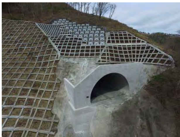
起点側坑口全景
