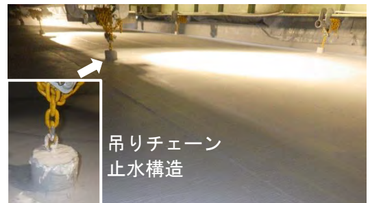
写真-2 防水床面（吊り足場上部）
