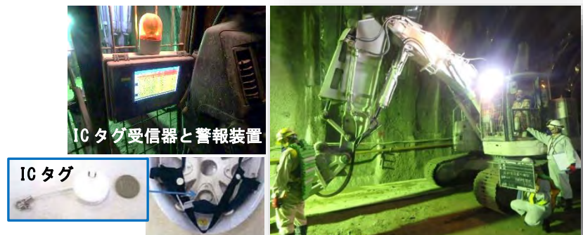
工事車両周囲エリア管理システム
