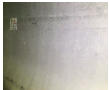
仕上がり状況
