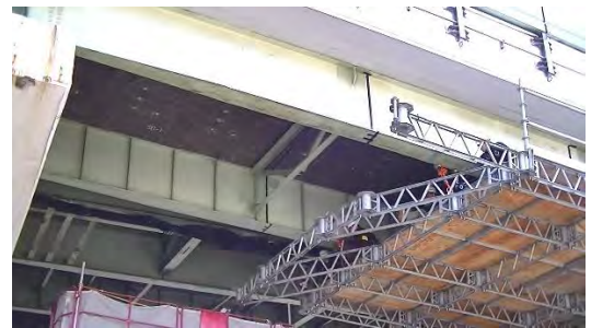
写真-1 クイックデッキ作業状況
