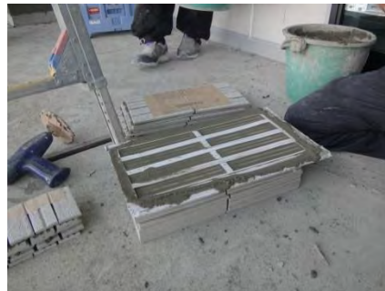
②タイル裏面張付け材塗り
