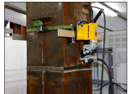
BOX 柱の横向溶接
