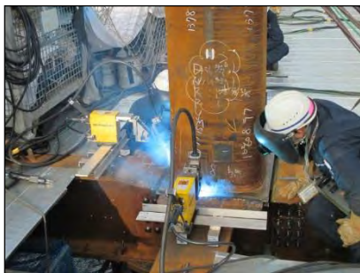
梁上フランジの下向溶接
