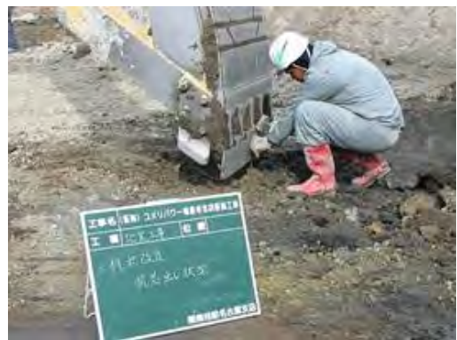
写真2 バケットによる杭芯位置出し
