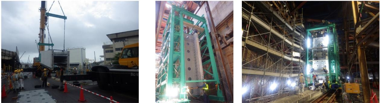
写真2 HPCa 部材投入・運搬状況
