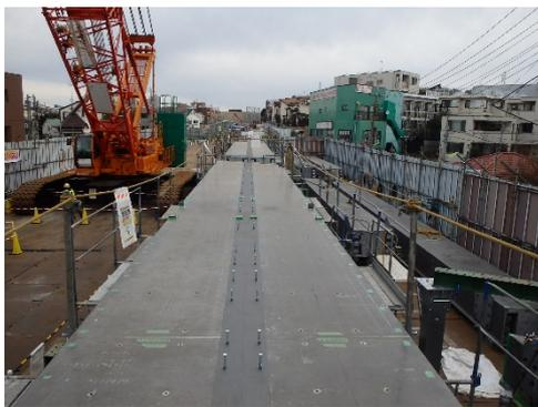
写真 1 ホロー桁地組状況
