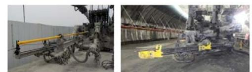
写真1 モルタル注入装置(左) / ロックボルト挿入装置(右)
