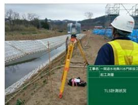
図3 起工測量実施(TLS)
