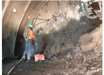
写真3 遠隔装填による爆薬装填
