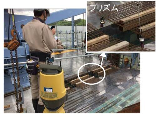
型枠セット測量状況
