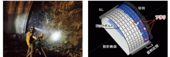
写真4 高速3Dスキャナによる計測(左) / 解析結果の表示(右)
