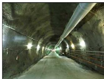
写真5 避難坑拡幅断面
