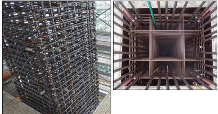
高強度せん断補強筋（ウルボン 1275）組立状況
