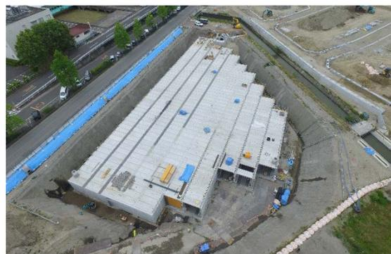
写真3 プレキャスト部材 据付完了
