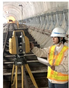
写真 1 坑内 TLS 測量状況
