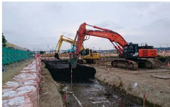
写真1 中層混合処理工法 施工状況
