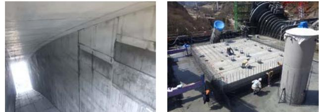
図7 プレキャスト使用箇所 (洪水吐水路部頂版、洪水吐操作室頂版)
