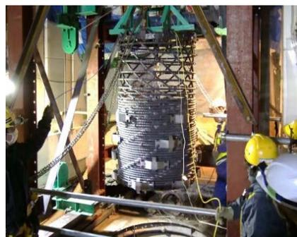
写真4 ウィンチ操作により短時間で伸展
