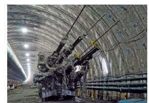
写真2 3ブームドリルジャンボによるロックボルト機械化施工
