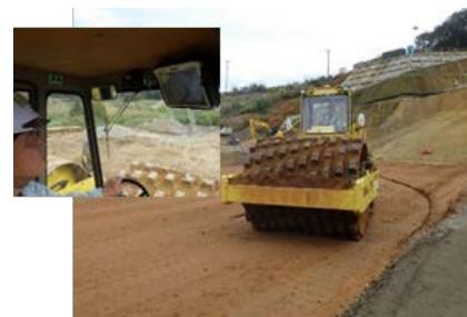
GNSS 締固め管理施工状況
