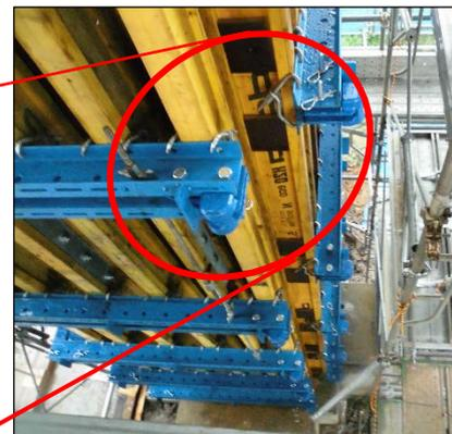
システム型枠隅角部組立状況詳細
