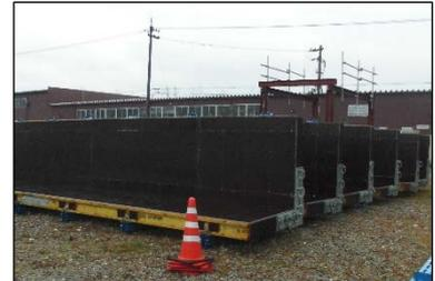
システム型枠地組 (2面分地組完了)
