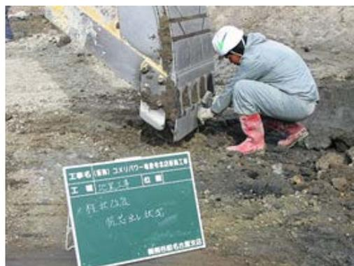
写真2 バケットによる杭芯位置出し
