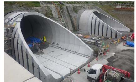
2. 大型プレキャストの採用事例②（2連ボックスカルバートへの適用）
