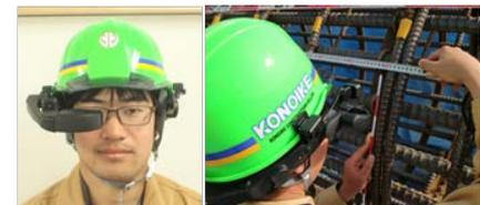
図12 ウェアラブル端末を用いた遠隔検査
