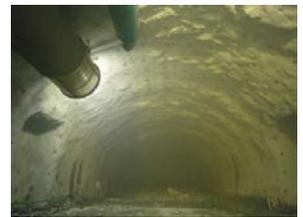
伸縮風管による吸引捕集換気
