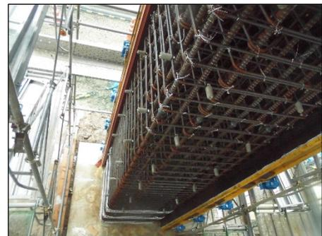
システム型枠建込2面分完了
