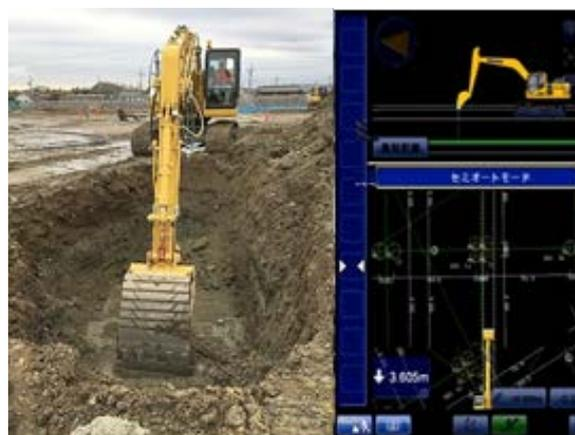
写真3 ICT 建機による杭頭レベル確認
