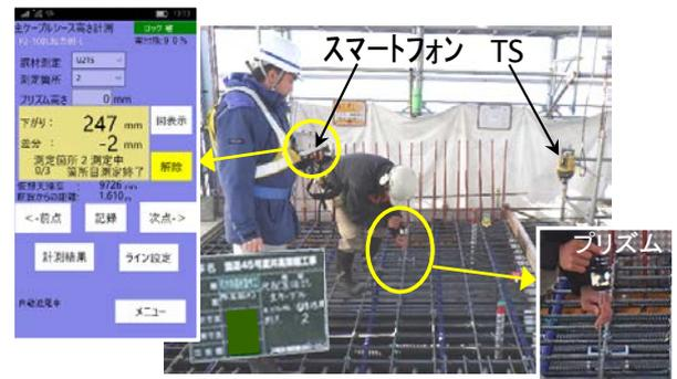
PC 鋼材配置高さ検測状況
