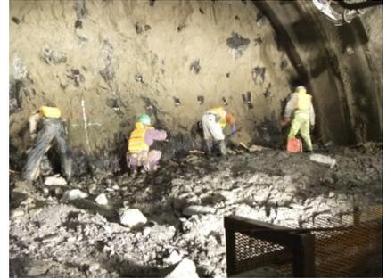
写真2 人力による装填作業
