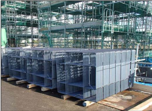
高強度せん断補強筋（ウルボン 1275）
