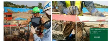
図11 電子黒板を用いた工事写真撮影
